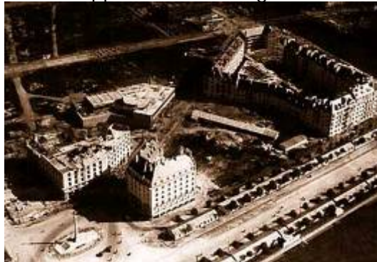
La reconstruction : Place Foch et rue du 11 novembre
