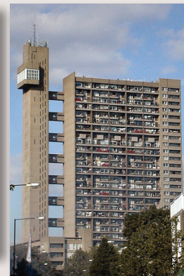
La construction de la Trellick Tower, dans le nord de Londres, a été achevée en 1972. Elle est la plus haute tour d'habitat social d'Europe, culminant à 98 mètres. Dessinée par Erno Goldfinger, elle est un exemple de l'architecture brutaliste de l'après-guerre.
