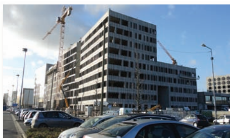
Le chantier des Rives de l'Orne depuis le parcotrain, au nord de la gare.
