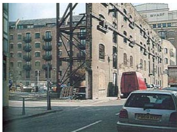
« Façadisme » pour la réhabilitation en immeubles de bureaux
