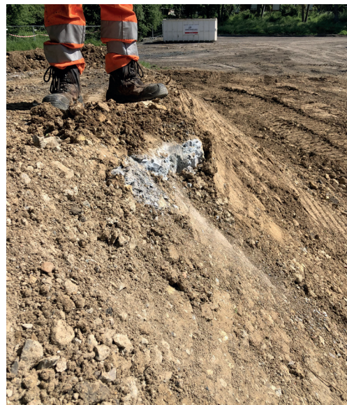
Photo : sol sur un chantier
