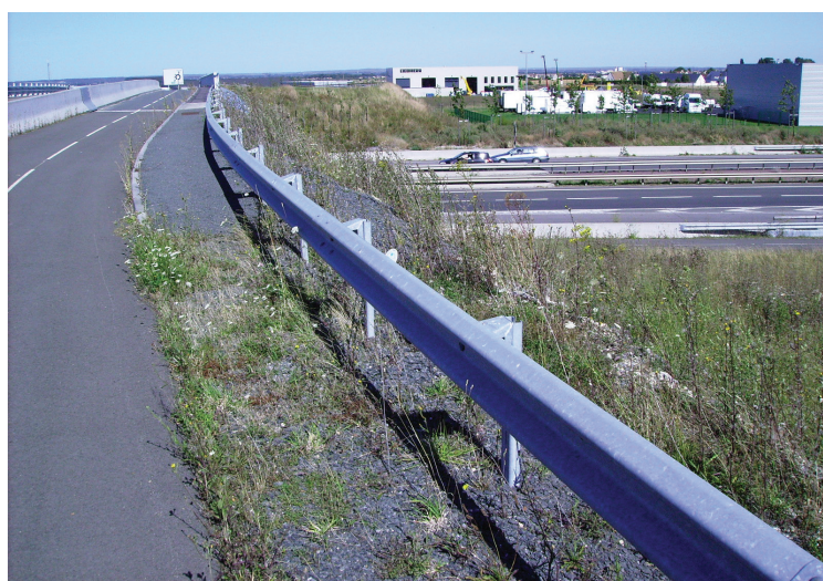
Une départementale à Iles, traversant le périphérique
