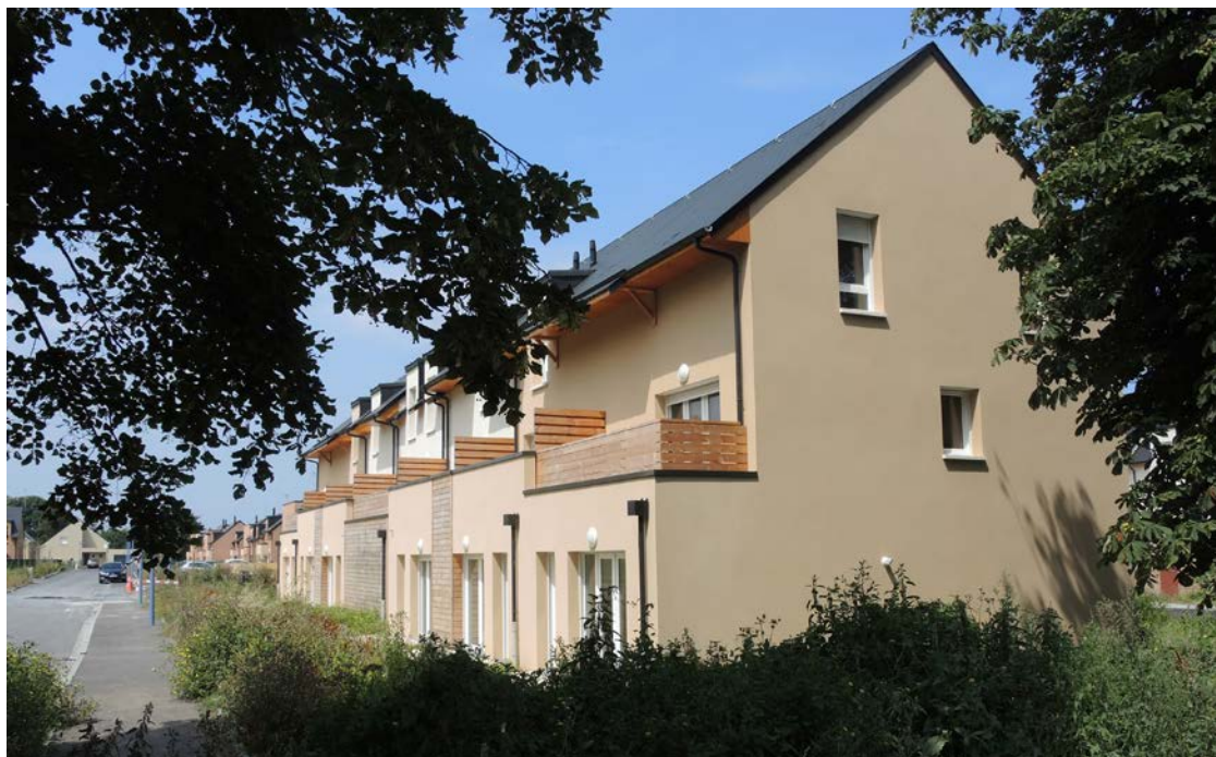
Logements locatifs sociaux en maisons accolées (Hermanville-sur-mer)
