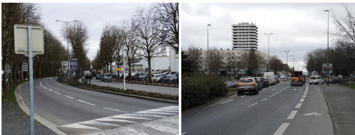
Figure 67 : Cours Montalivet et rue du Chemin Vert, entrées de ville dont le PDU* souhaitait la requalification mais qui gardent aujourd'hui un caractère très routier.
