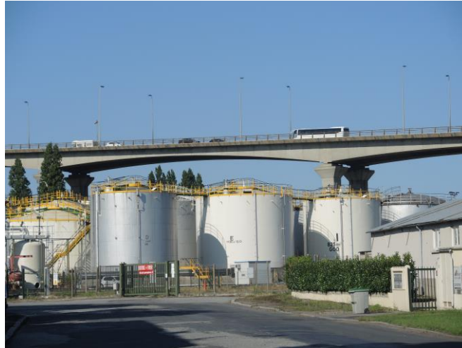
Figure 69 : Les dépôts pétroliers situés à Mondeville sous le viaduc de Calix
