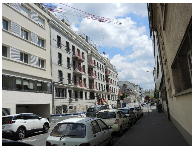
Figure 10 : Un fléchage de l'urbanisation vers le corridor TCSP existant a été observé sur le temps de mise en œuvre du PDU, comme ici rue de la Miséricorde à Caen.
