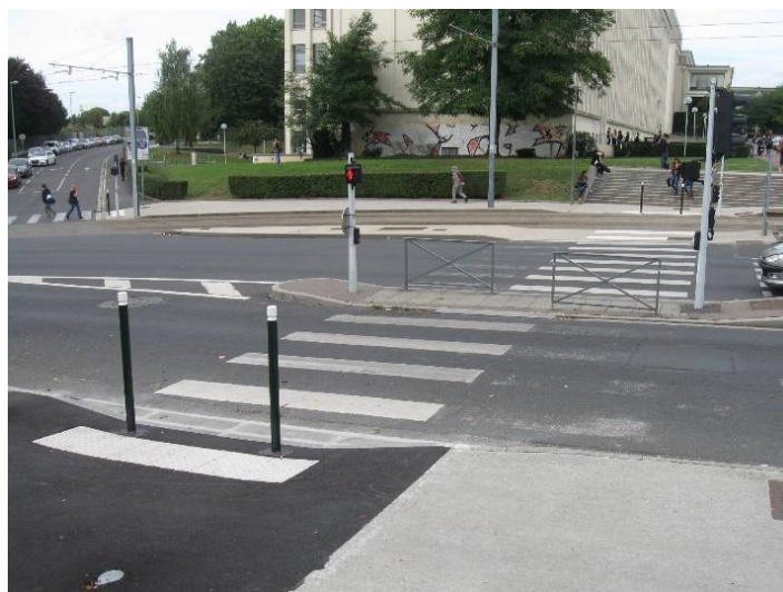
Figure 74 : exemple de mise en accessibilité des traversées piétonnes sur l'esplanade de la Paix, devant l'Université, favorisant l'accès des personnes en situation de handicap à l'arrêt du tramway
