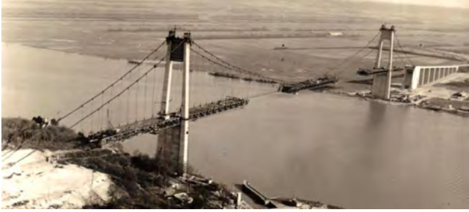
Pont de Tancarville : construction de 1955 à 1959
