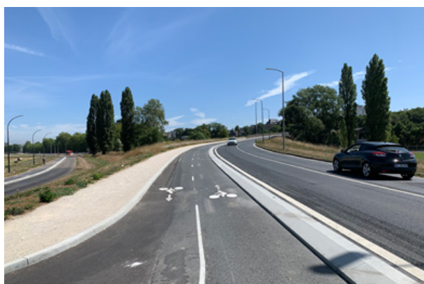
Piste cyclable bidirectionnelle le long du Viaduc de la Cavée à Caen
