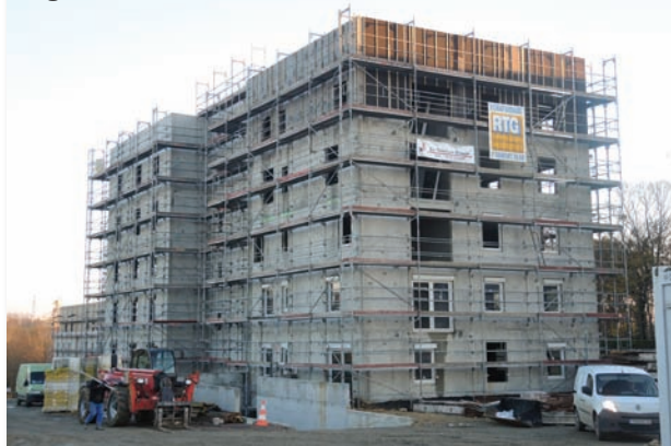
Hérouville Saint-Clair : logements en construction
