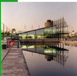
Maison des éclusiers
