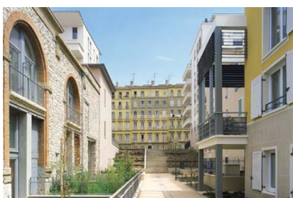
Réhabilitation de logements mêlant le neuf et l'ancien
